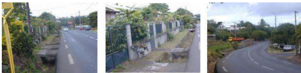
De la ravine Langevin à la rue des pervenches : la route
