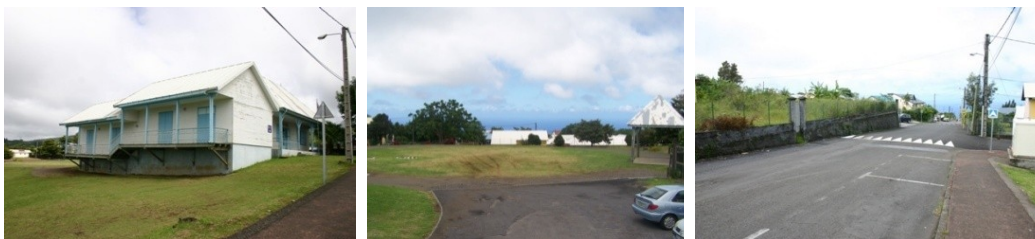
Mairie-annexe – bibliothèque et abords immédiats - réseau viaire
