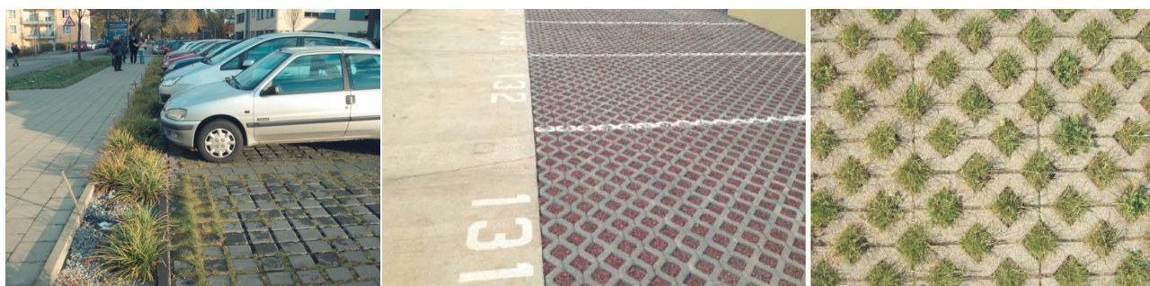
Illustrations de matériaux drainants pour les espaces de stationnement : pavage/alvéoles scories ou engazonnées
