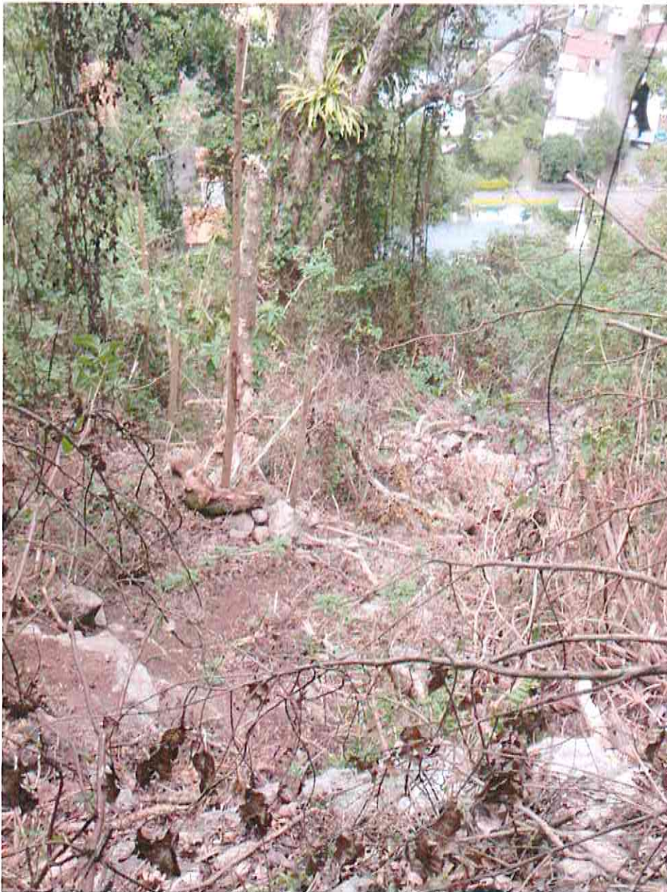
Aperçu du couloir encombré de blocs
