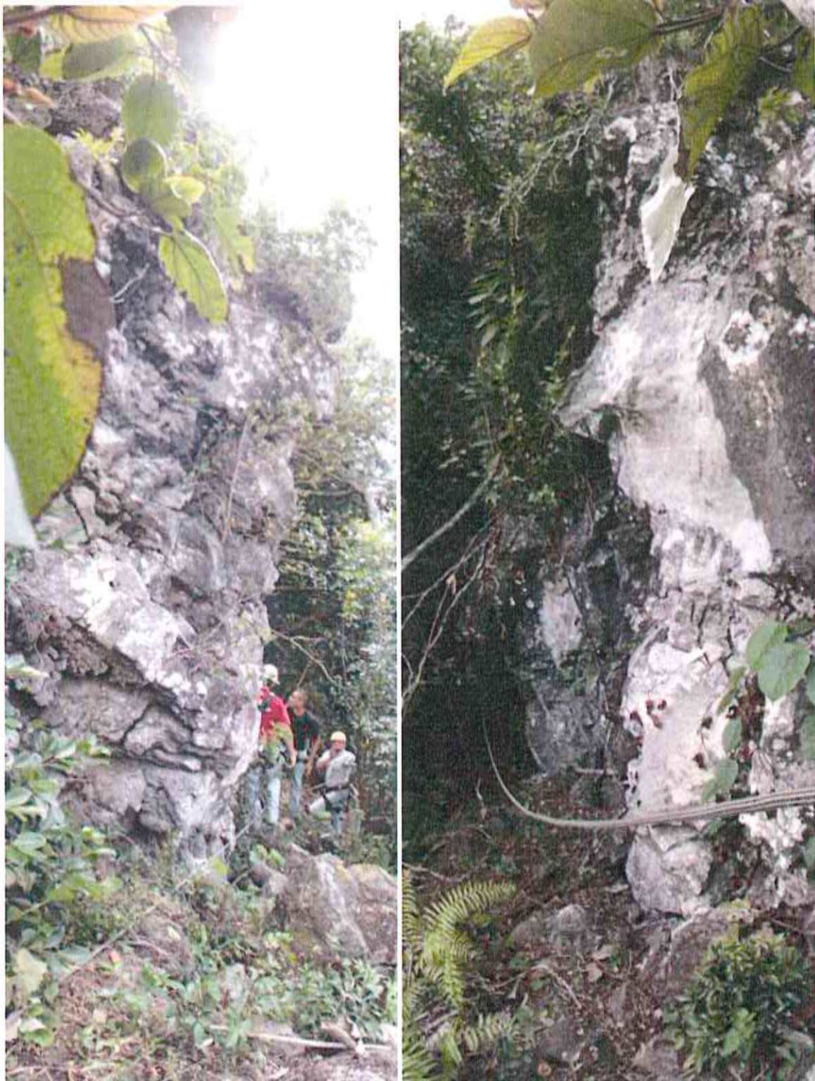
Figure 17 – Zone aval de la masse rocheuse.
