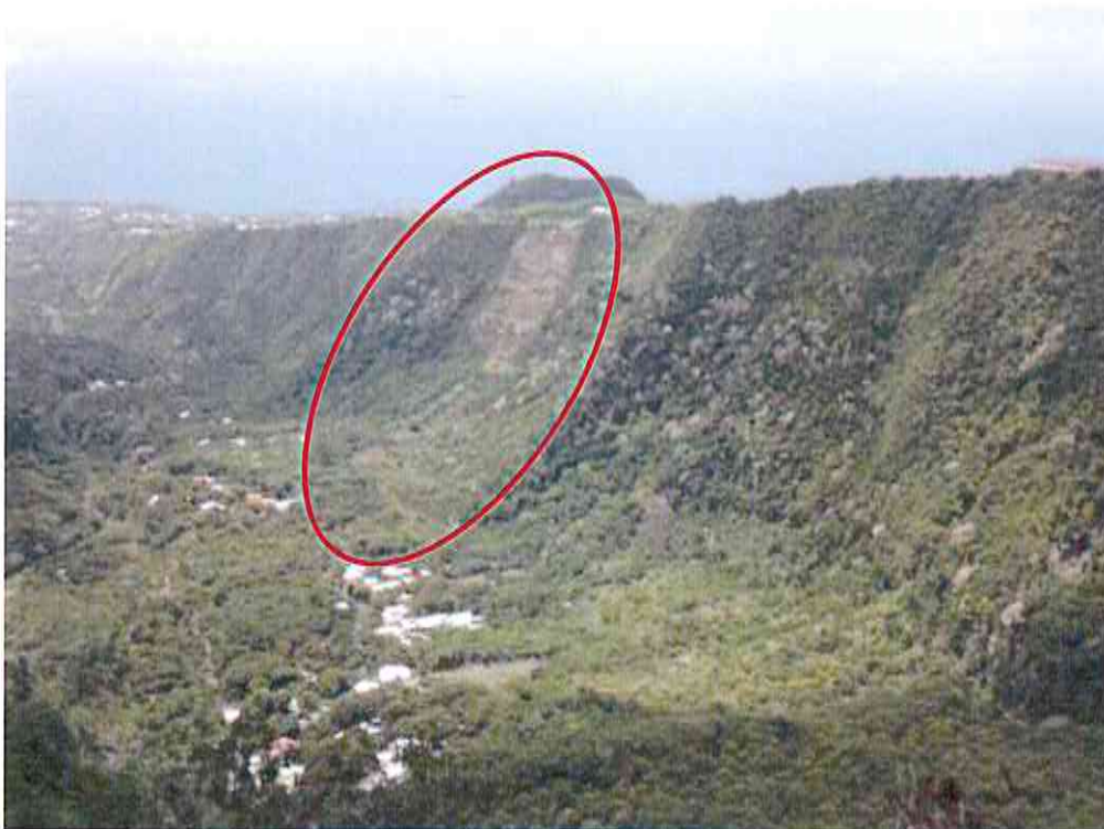
Figure 19 – Effondrement d'une partie du rempart en rive droite de la Rivière Langevin au Sud d'Ilet à Diable (photo du haut prise en juillet 2010, photo du bas prise en novembre 2014).
