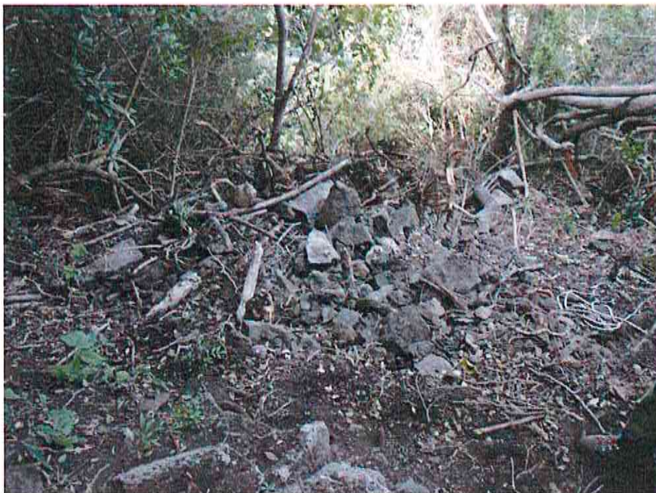
Matériaux éboulés retenus par la souche
