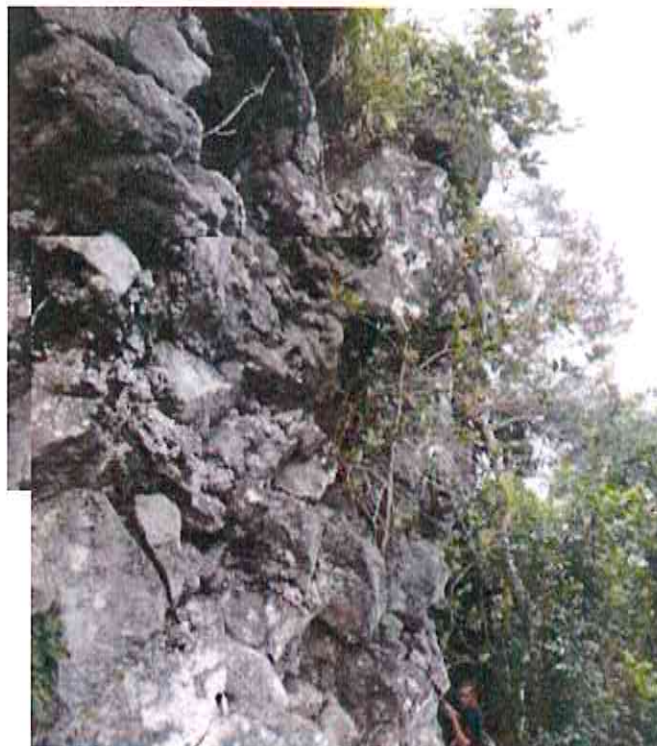
Figure 16 – Zone aval fracturée de la masse rocheuse.
