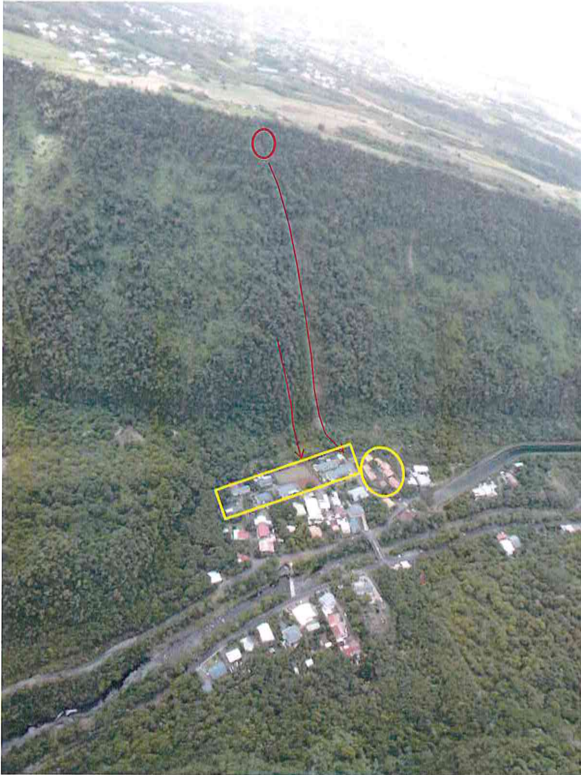
Vue d'ensemble. Rempart environ 300m de haut. Localisation de la masse de 400m 3 en haut de rempart. Trajectoires des deux événements en ligne rouge. Zones évacuées en jaune.
