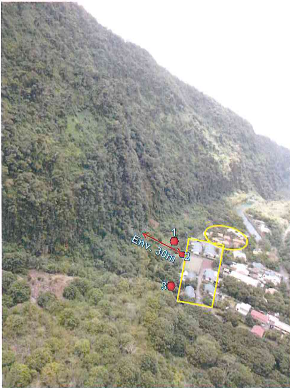
Figure 6 – Localisation des blocs éboulés le 09 novembre 2014. Zones évacuées le 22 novembre entourées de jaune. 1 : voir Figure 8 et 2 : voir Figure 7.
