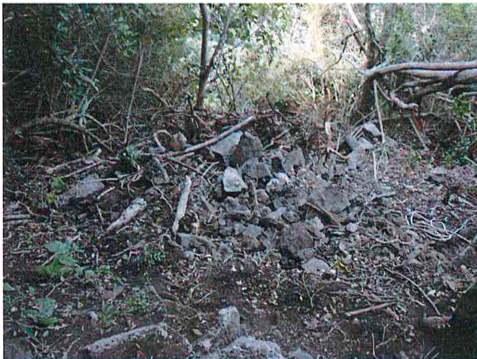
Matériaux éboulés retenus par la souche
