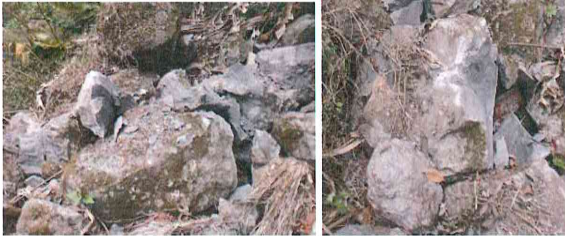
Figure 13 – Blocs éclatés dans le cône d'éboulis au pied de la Combe Sud.
