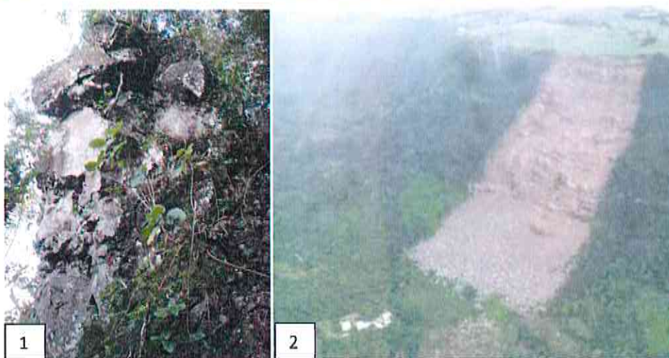
Figure 2 : 1. VUE AVAL DE LA GRANDE MASSE. - 2. GLISSEMENT DE TERRAIN DE 2009 EN RIVE DROITE
