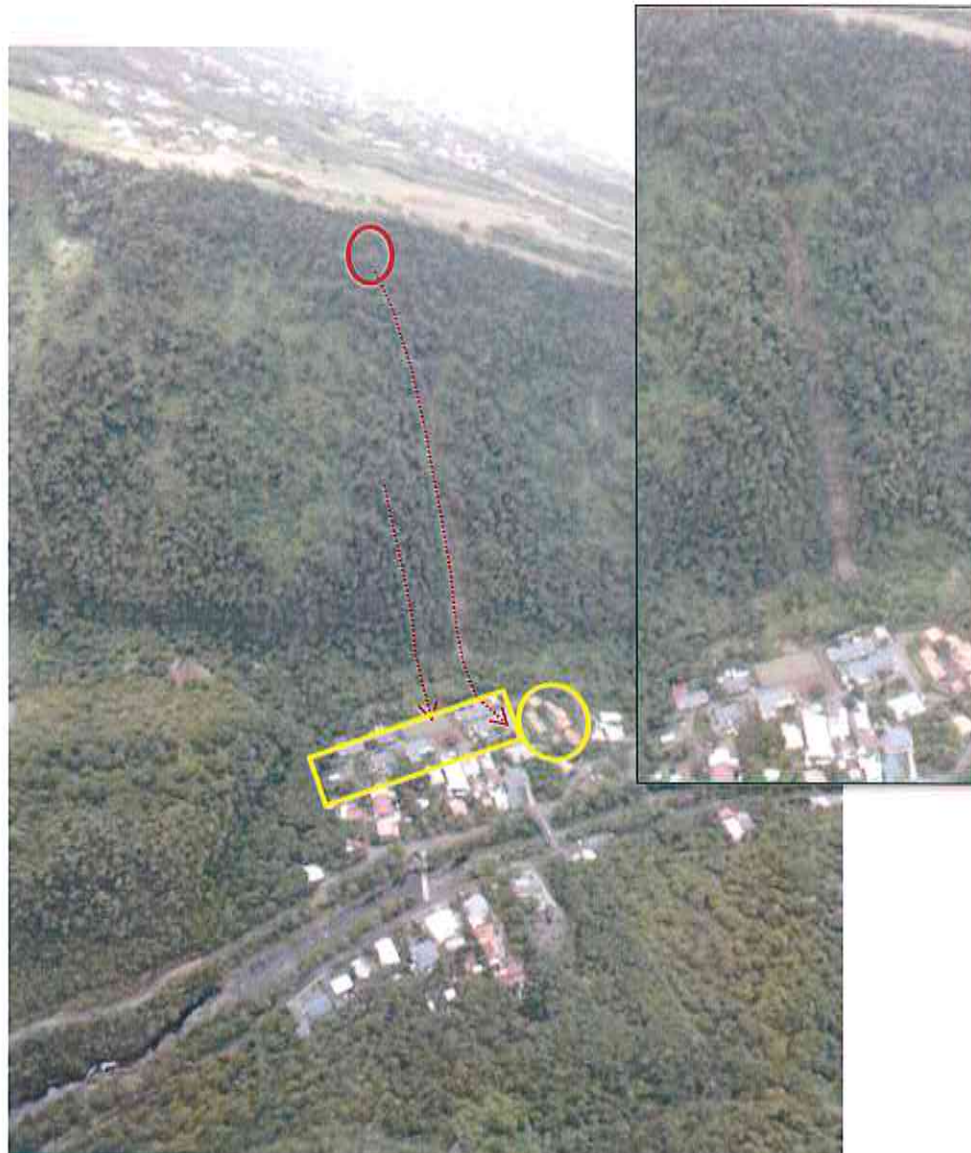
Figure 5 - Vue d'ensemble. Rempart environ 300 m de haut. Localisation de la masse de 400 m 3 en haut de rempart (cercle rouge). Trajectoires des deux événements du 09 novembre 2014 en lignes rouges pointillées. Zones évacuées le 22/11/14 en jaune (cercle : école).
