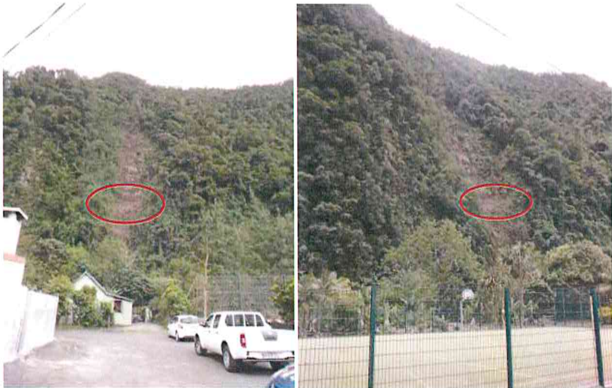
Figure 11 - Vue depuis l'école (photo de gauche) et depuis le terrain de sport (photo de droite) du couloir de propagation des blocs éboulés. On note la présence d'une vire située à environ 40 m du sol.
