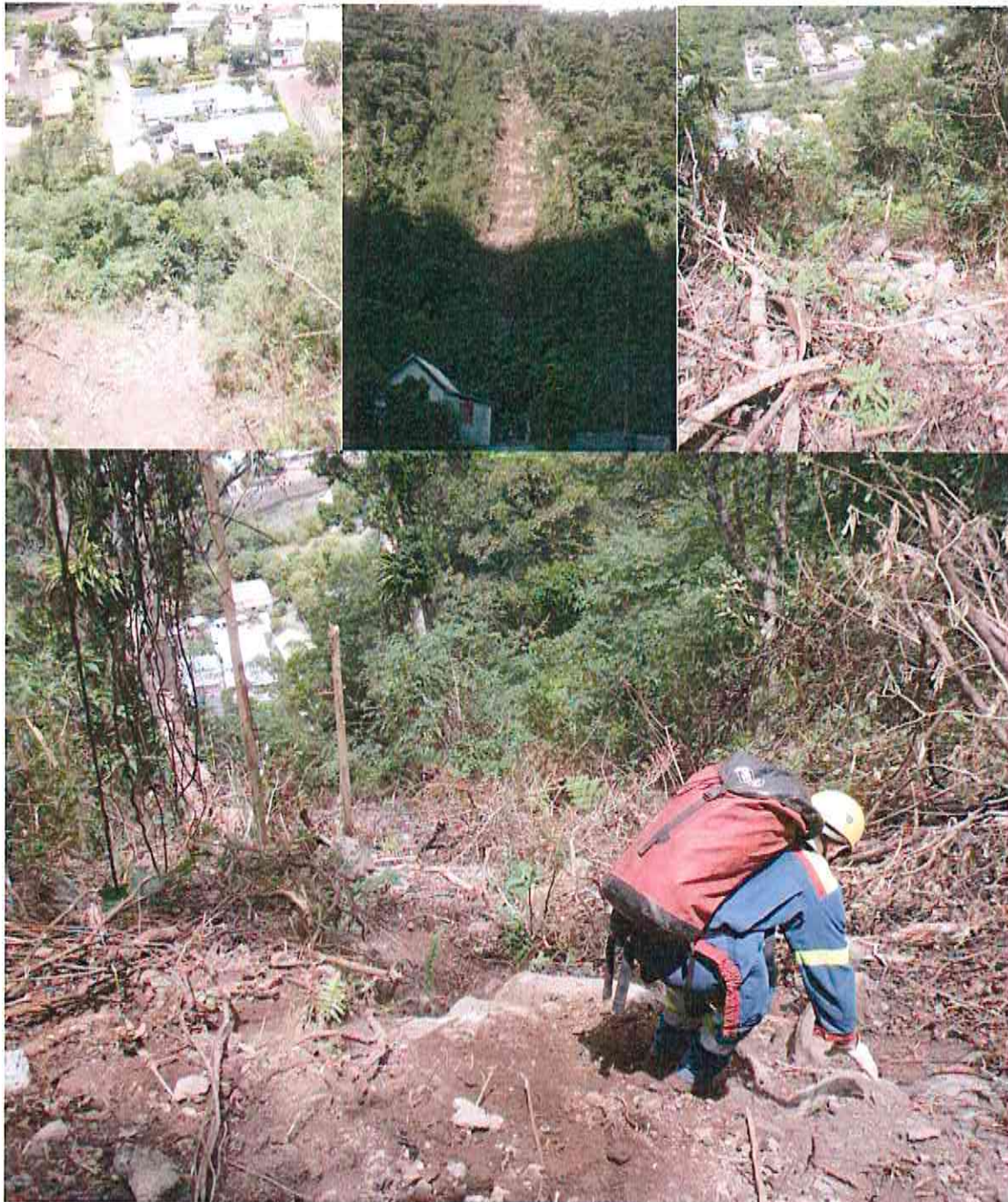
Figure 3 : VUES DU « GRAND COULOIR » SITUE EN SURPLOMB DES HABITATIONS (PHOTOS SAGE/SEGC)
