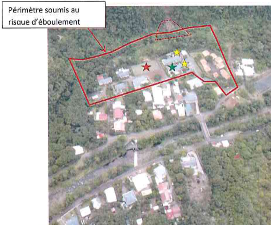
Figure 10 – Localisation (selon les témoignages des habitants) des ébats de roches qui auraient été projetés lors de chutes de blocs : étoiles jaunes lors de l'événement du 09/11/14 (parcelle 313), étoile rouge sur le terrain de sport (2013 ?), étoile verte en 2011 (parcelle 311). On note le cône d'éboulis au pied de la combe sud (pointillé rouge).
