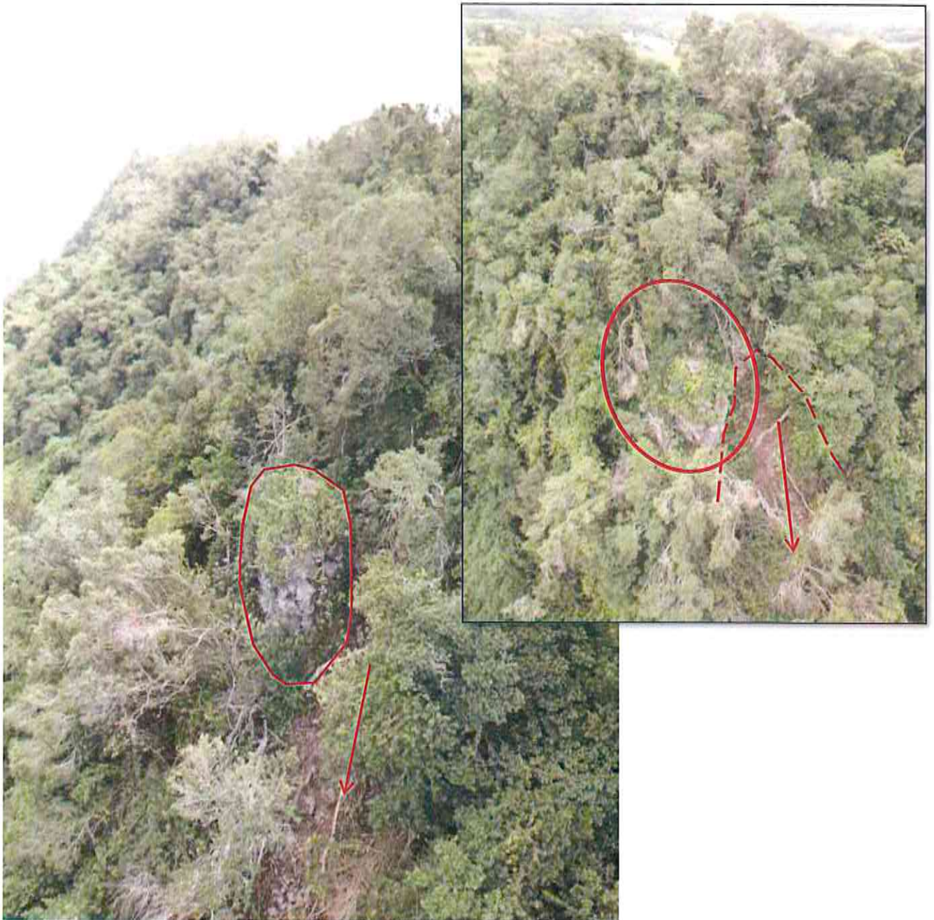
Figure 14 - Masse rocheuse de 400 m 3 située à environ 20 m sous le sommet de rempart. Départ de blocs le 09 novembre 2014.
