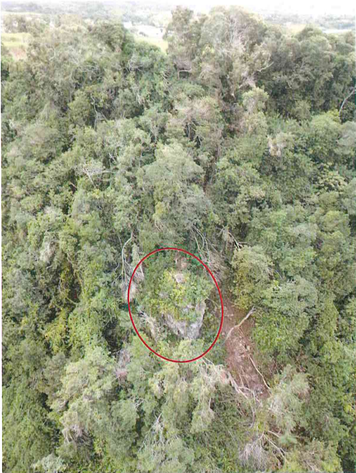
Masse rocheuse de 400m 3 en sommet de rempart (à environ 20 m sous le sommet). Départ de l'un des 2 événements.
