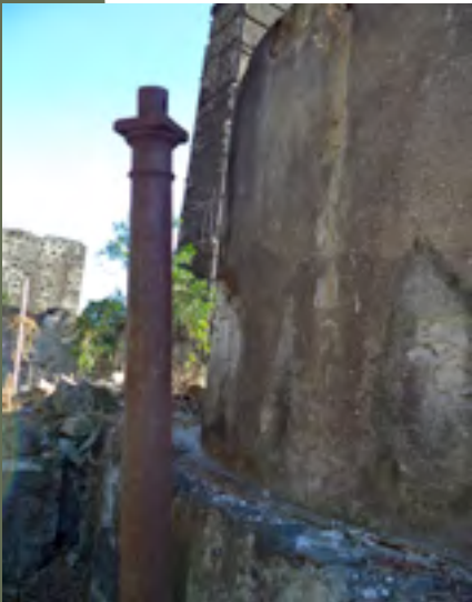
Les vestiges d'une première machine à vapeur (2eme moitié du XIXe siècle)
