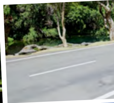
Langevin : mise en place de la signalisation horizontale et verticale pour un montant de 17 000 €
