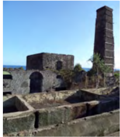
Les bacs de décantation..
