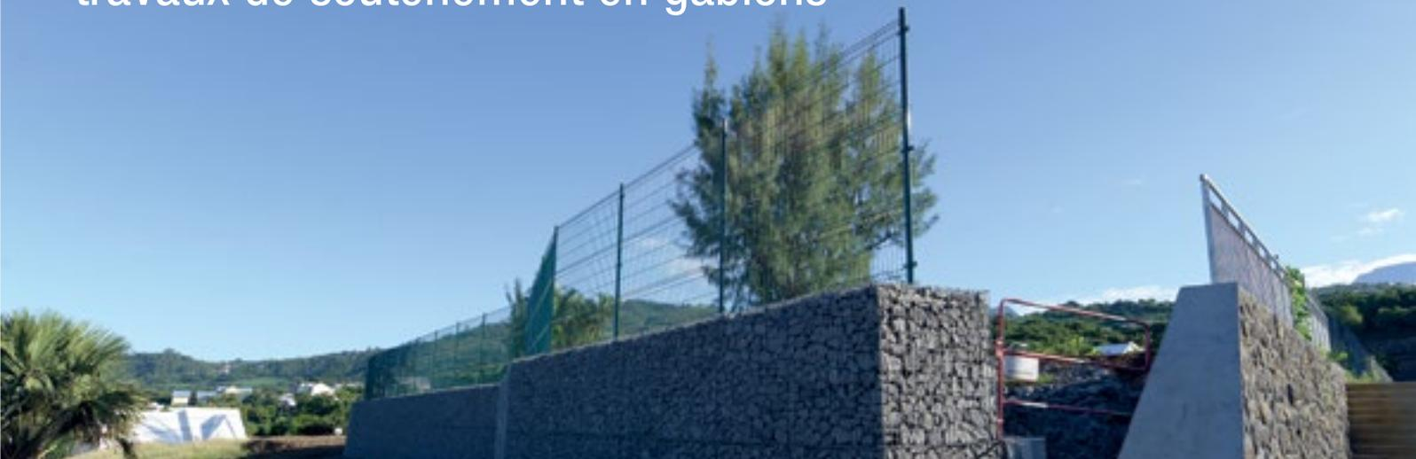
Après avoir montré leurs compétences dans la réalisation de travaux d'aménagements routiers et de construction de murs de soutènement, les agents du service VRD de l'Entreprise Municipale ont désormais une nouvelle corde à leur arc : la construction de murs de soutènement en gabions.
